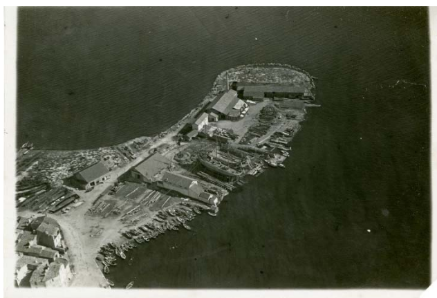
Construction en navale en 1930
